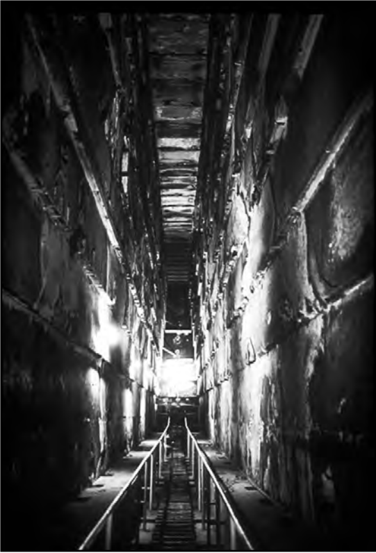
圖表 10.19 – 1978 年的大走廊，如同 1880 年的圖解所示，這裏有兩個斜坡，通往豎井的入口及其與水平通道的接合點。
